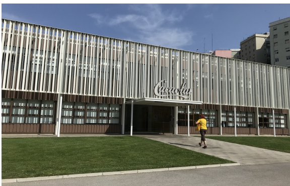
Figura 97: Exterior de la fàbrica. Font: Imatge pròpia
